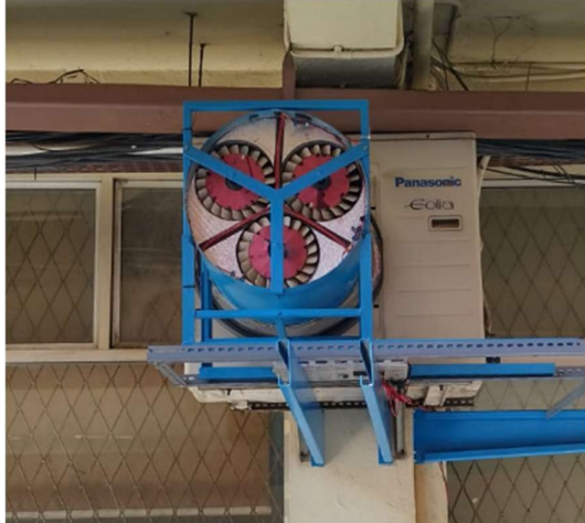
Gambar 8. Pemasangan prototipe generator horizontal blade.
